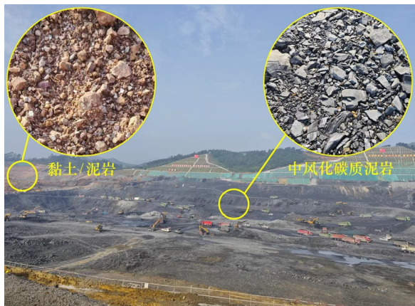
(a) 马道枢纽挖掘现场与土石方类型
