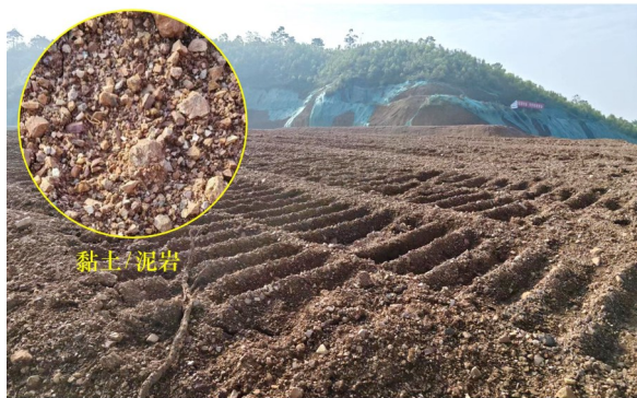
(b) 马道枢纽抬填造地现场
