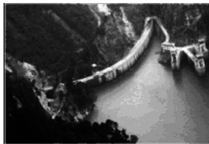
图 3 沙牌拱坝震后航拍照片
