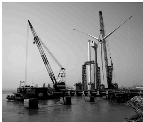
图6 风机陆上拼装
