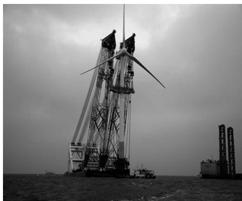
图7 风机海上整体吊装
